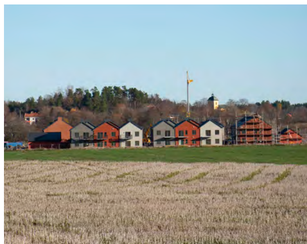
Just nu byggs en första etapp med mindre flerfamiljshus i Mölnaäng
