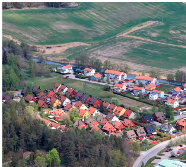
Byggnation av Infart västra Trosa möjliggör fortsatt utveckling och utbyggnad västerut
